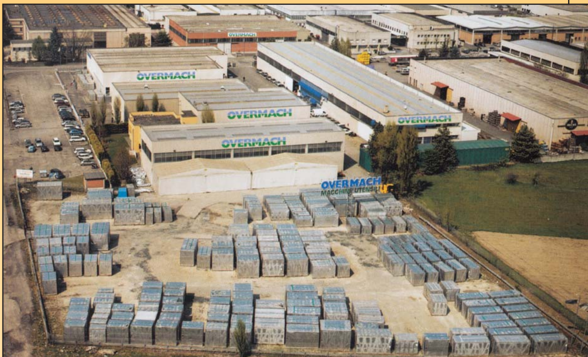
VEDUTA AEREA DELLA SEDE DI PARMA DI 48.000 m 2 CON 14.000 m 2 COPERTI/AIR VIEW OF PARMA SEAT OF 48.000 s.mt. WITH 14.000 s.mt. COVERED AREA
